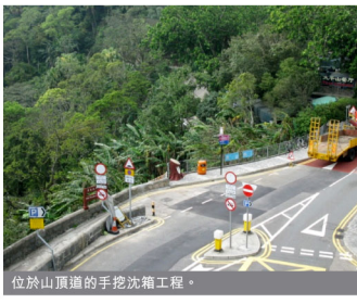
位於山頂道的手挖沈箱工程。
